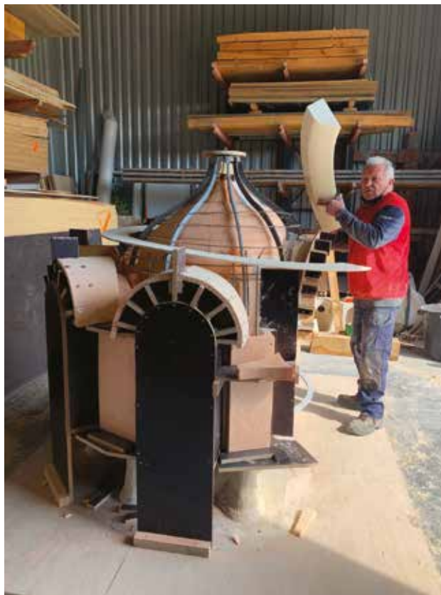
Coffrage pour reconstruction à l'identique
