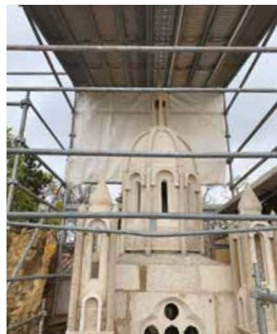
Chapelle du Christ au Mont des Oliviers éléments en cours de restauration (pour une reconstruction à l'identique)
